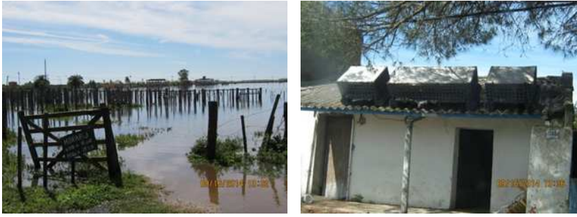
Figura 23. Hipódromo y vivienda inundada en evento de setiembre 2014, Fotografías de ISJ.
